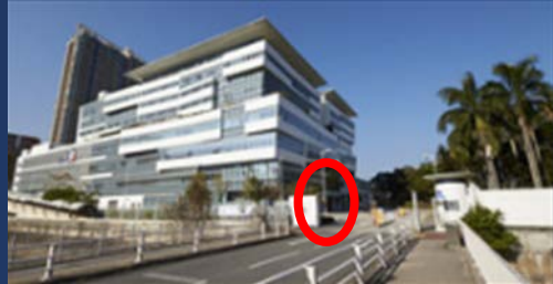
Front Door of the HKSI Main Building 香港體育學院主大樓正門
